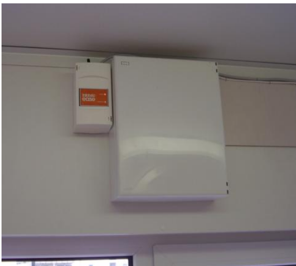
En ATM-modul monterad tillsammans med en bodetableringscentral. Notera gärna antennen som förbinder modulen med centralenheten på byggarbetsplatsen.
